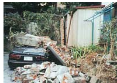
煉瓦造りの塀は完全に倒壊した。
