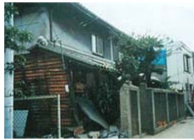
東(塩屋駅)に向かうほど周辺の被害は大きい。
