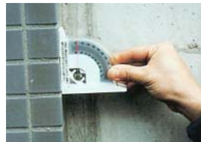
傾斜は確認されなかった。
